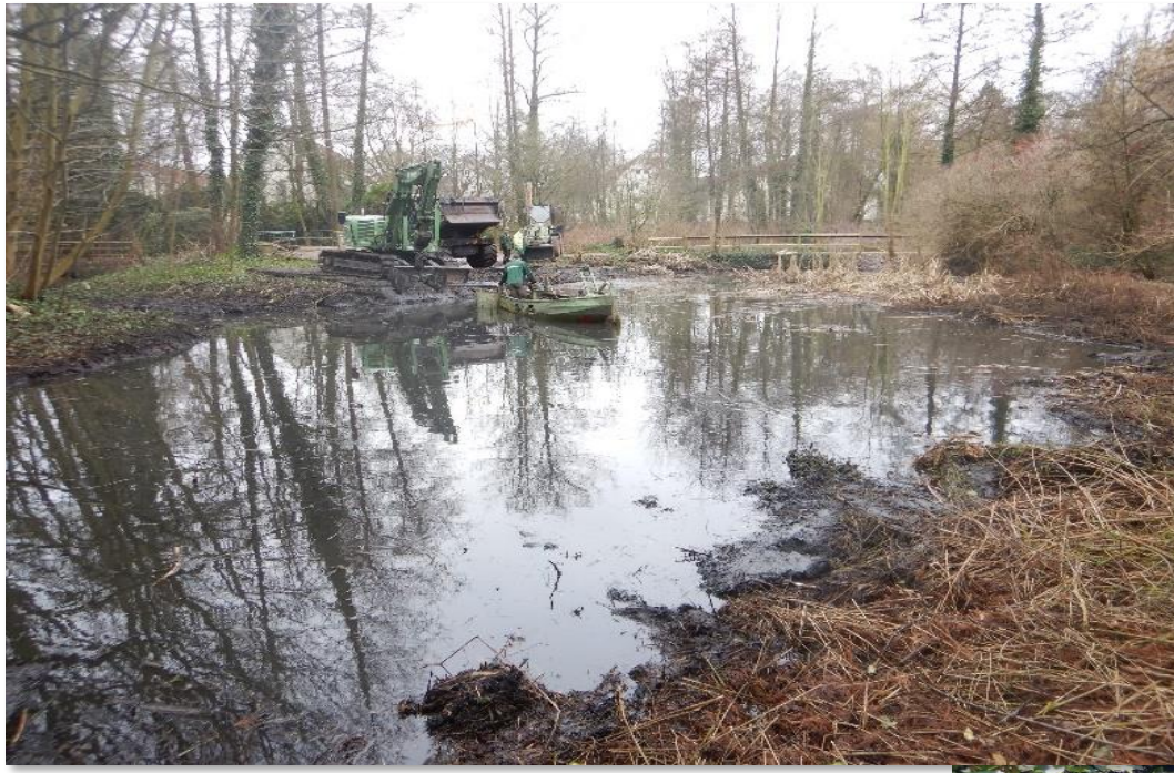
Abb. 2: RHB in der Parkanlage Fischerspark, Hamburg-Wandsbek, während einer Entschlammungsmaßnahme im Winter 2022/23 (Bildquelle: Planula 2022).
