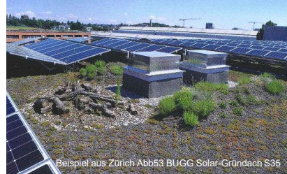
Beispiel aus Zürich Abb53 BUGG Solar-Gründach S35
